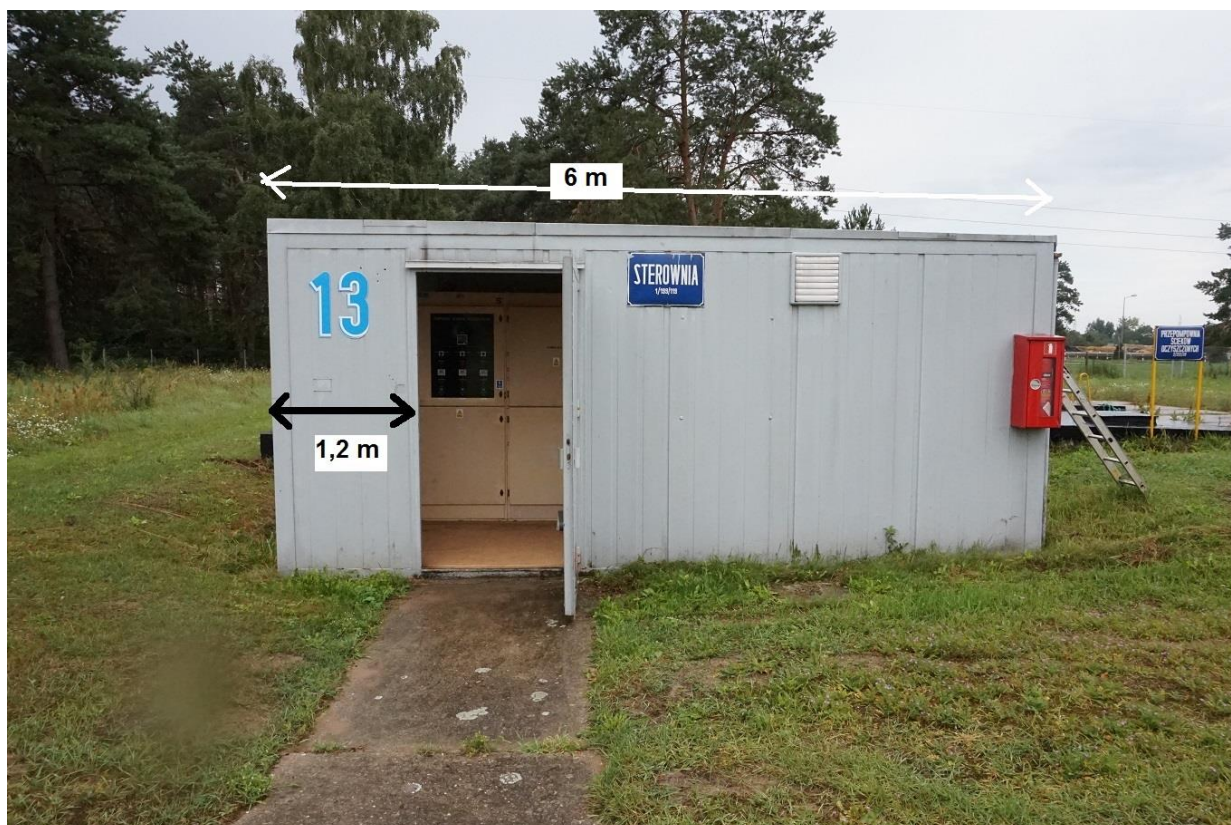
Rys. 1 - Widok likwidowanego kontenera od strony wejścia
